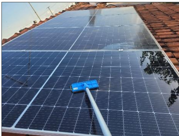
Fotografia 4 – Inspeção e limpeza dos painéis solares
