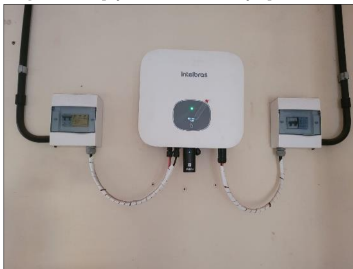
Fotografia 1 – Inspeção visual em manutenção preventiva
