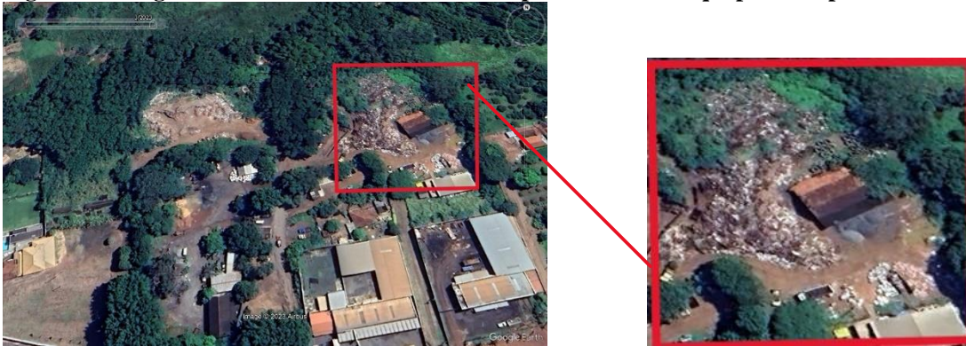
Figura 1 – Imagem de satélite do almoxarifado 2 da prefeitura. Destaque para o depósito de resíduos sólidos
