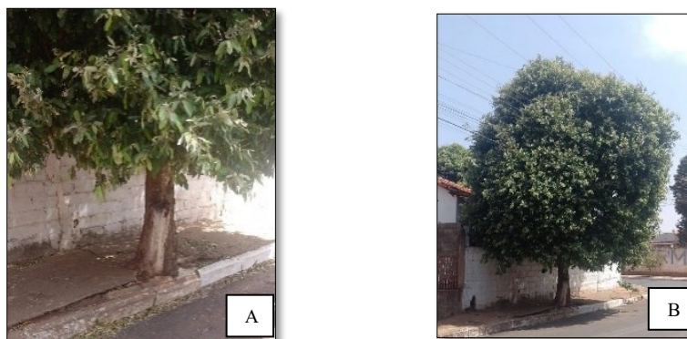
Figura 1 - Árvore de Oiti ( Moquilea tomentosa ) rompendo a calçada (A) e com a copa entre a fiação (B)
